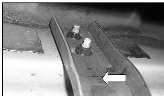
Se muestra el bracket instalado.
