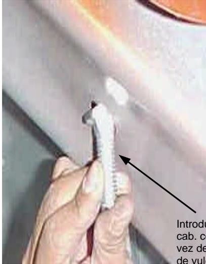
Introduzca el tornillo cab. coche rec. Una vez dentro, gire 1/4 de vuelta para mantenerlo en el galuz.
